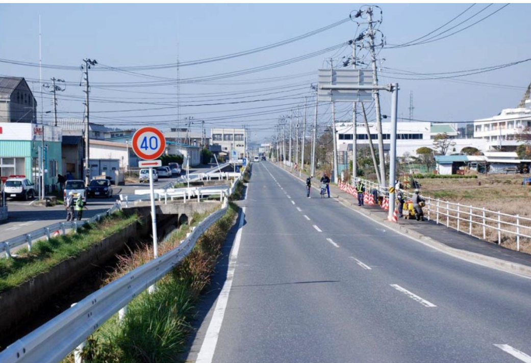
復旧後の 東松島市小野地区
