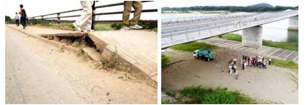
左：歩道部分が隆起しているザンビアの橋。そのまま放置すれば、橋本体を傷めることになる。 右：岐阜県の各務原大橋で留学生を対象に行われた特別プログラム研修。先端技術を使った点検のデモンストレーションが行われた。
