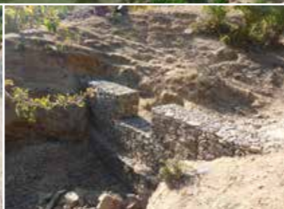
左：保水力の観測施設。右：土砂をせき止め、山を安定させるチェックダム。
