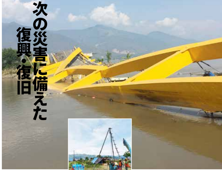
液状化が発生した地域ではボーリング調査を継続中。対策として、水抜き井戸の建設も計画されている。
