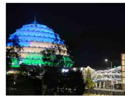
2016年に完成したルワンダ発展の象徴でもある「キガリ・コンベンションセンター」。ドーム型の屋根は、夜はルワンダ国旗や来賓の国旗の色に合わせてライトアップされる。
