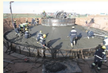
風力土台の建設風景
