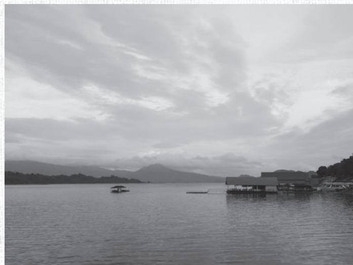
日本の協力で作られたナムグムダム。広大な貯水湖にためられた水は発電に使われ、その後はラオスを大きく横切ってメコン川へと注ぐ
