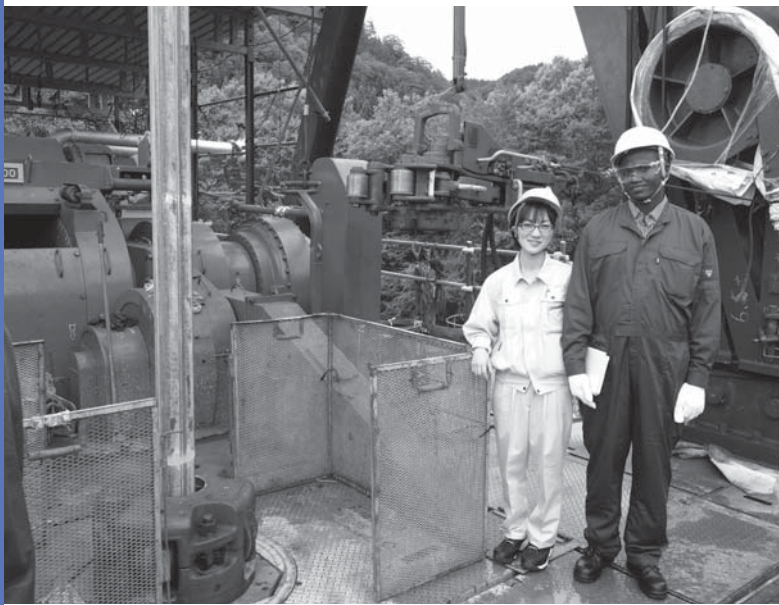
地熱開発の研修に同行し、秋田県湯沢市の掘削現場を訪れた緒方さん。ケニアの研修員と共に
