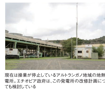
現在は操業が停止しているアルトランガノ地域の地熱発電所。エチオピア政府は、この発電所の改修計画についても検討している
