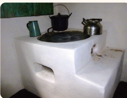
地面に石を置いただけのかまどを、少量の薪で調理ができ、煙が部屋に充満しないように改良した
