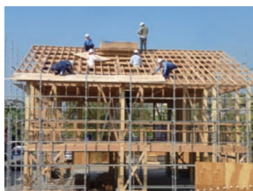
ラオスの大工に加工した木材の組み立て方を指導し、モデルハウスを建てる
