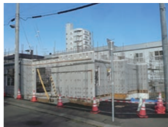
北海道での寒冷地対応住宅の建設風景。断熱パネル兼用型枠を設置中
