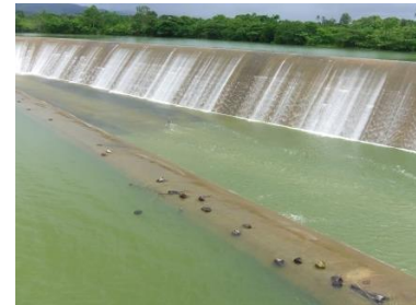
ボホール灌漑事業で整備したマ リナオダム
