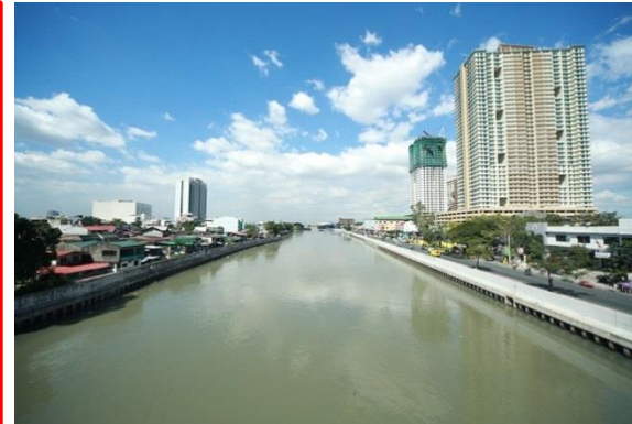
上：パッシング・マリキナ川河川改修事業
