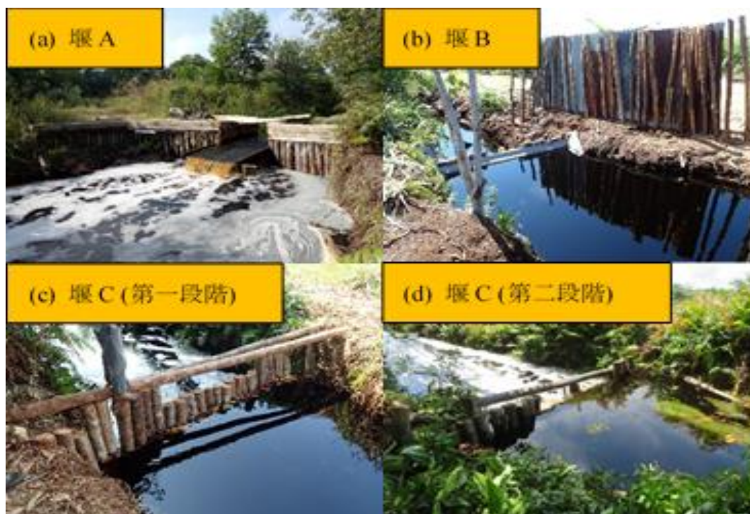
図9 流れの早い堰 (A) と遅い堰 (BとC)
