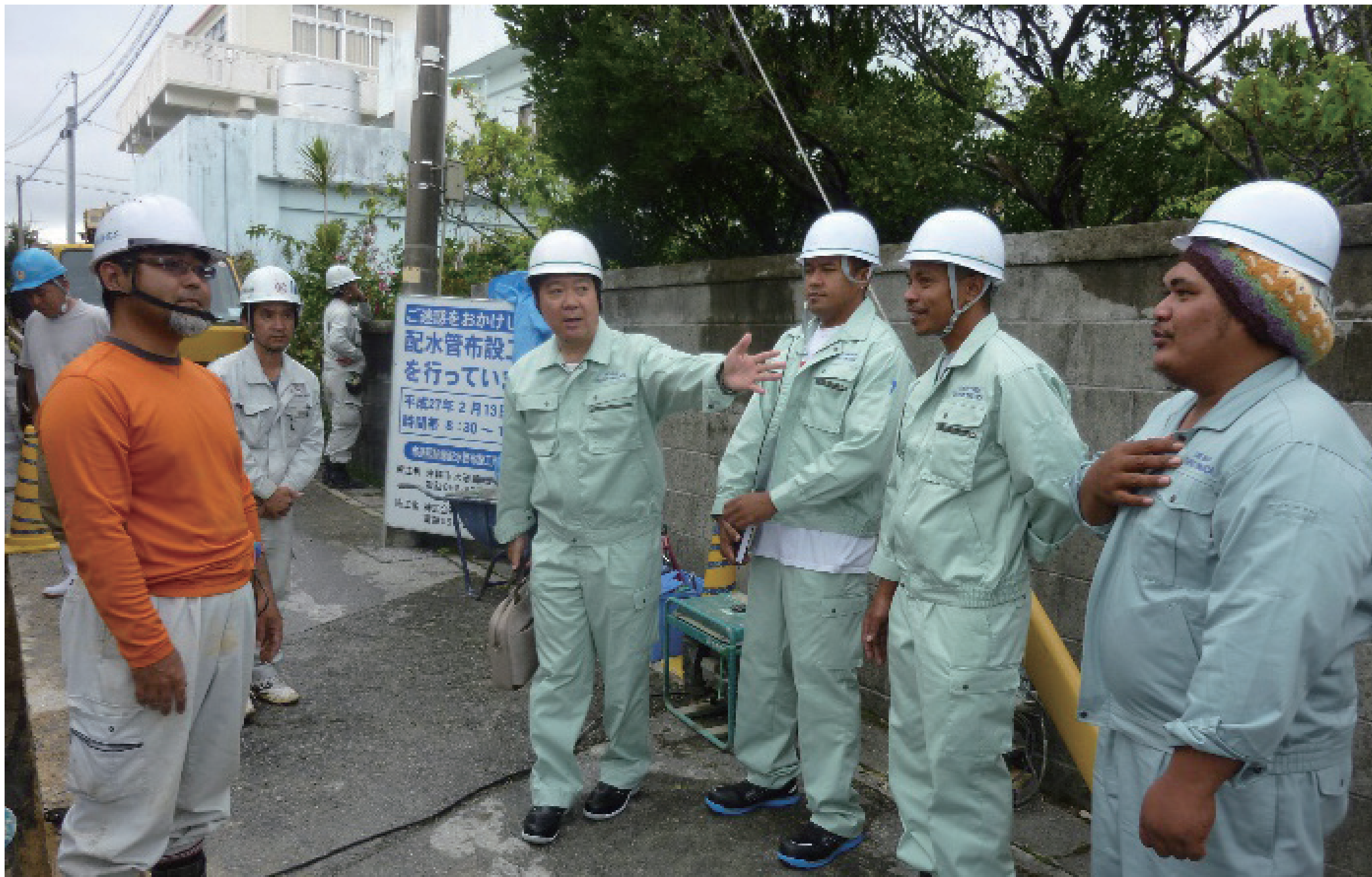
はいかんこう じ じっしゅう おきなわ し かんこう じ くみあいきょうりょく 配管工事実習（沖縄市管工事組合協力）
