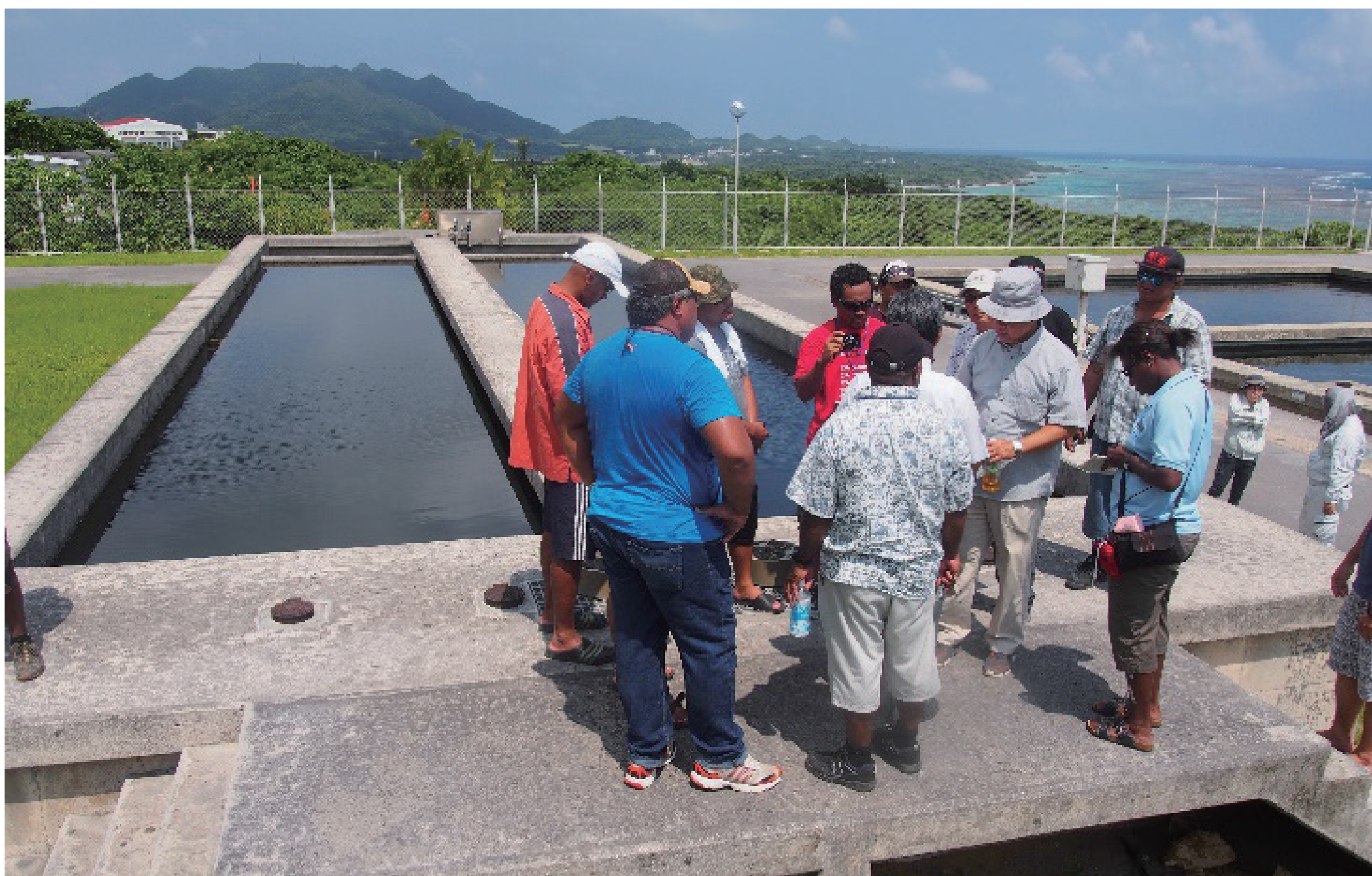
せいぶつじょう か ほう じょうすいじょう いしがきじょうすいじょ 生物浄化法による浄水場（石垣浄水場）
