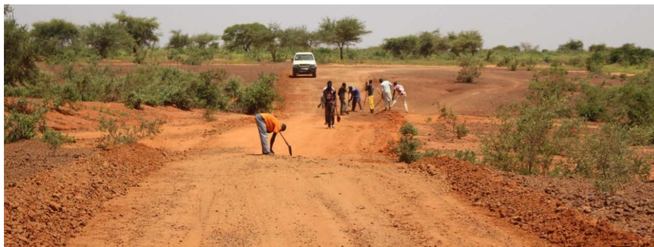
道路整備:(2)グレーダーはパワフルですが、細かいところは行き届きません。車のパンクの原因となる岩をスタッフの手で取り除いていきます。ニジェールでは、道路は町へのアクセスだけでなく、治安維持のためにも重要です。
