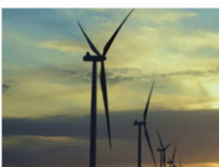
写真提供：SBエナジー
