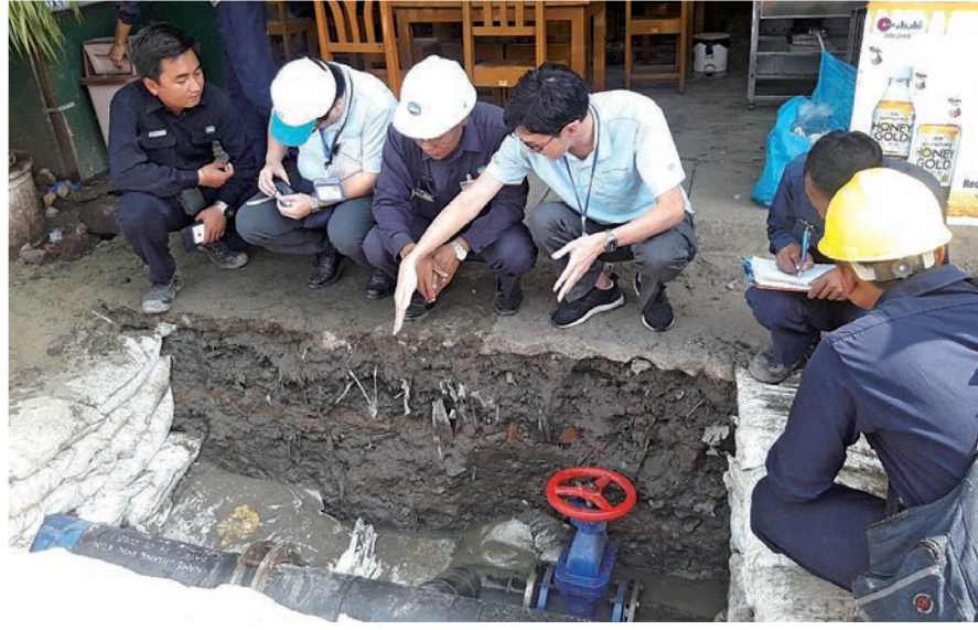
バルブと流量計を水道管に取り付ける正しいやり方を学ぶ職員
