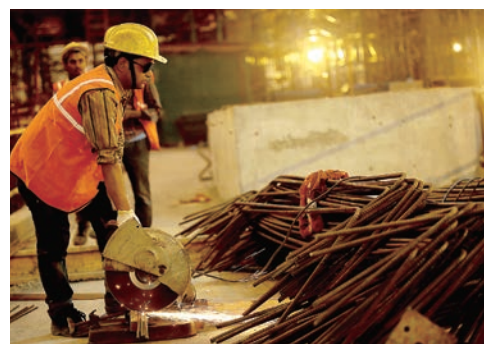
工事現場では事故が起きないように細心の注意を払います
