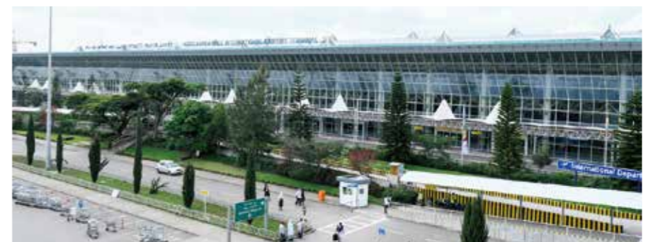
完成間近の新乗客ターミナル
