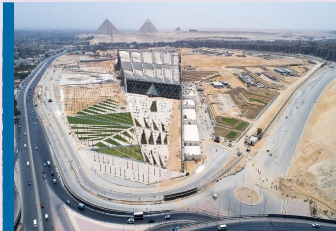
建設中の大エジプト博物館（GEM）
