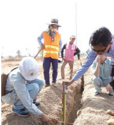
上水道管路の維持管理能力向上支援（ラオス）
