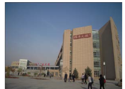
本事業で建設した内蒙古医科大学 図書館
