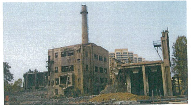
拆除中的旧锅炉房（兰棉厂）
