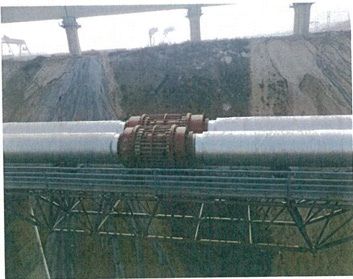
南山路2xDN1200供热管网架空管道补偿器
