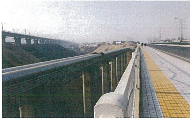
南山路小金沟2xDN1200 供热管网架空管
