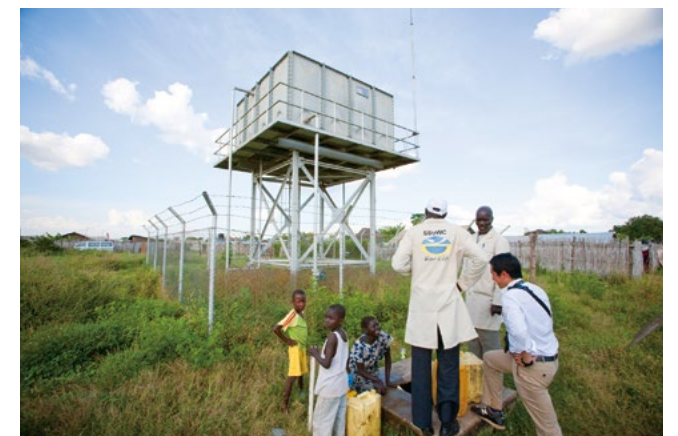
南スーダン都市水道公社水道事業管理能力強化プロジェクト 写真：久野真一/JICA
