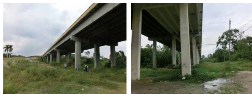
7 Puente sobre el Rio Puerto Escondido (185m)
