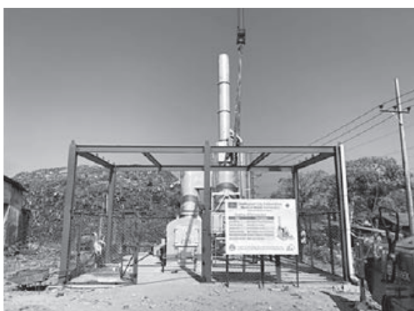
写真-4 医療系廃棄物焼却炉の据付工事
