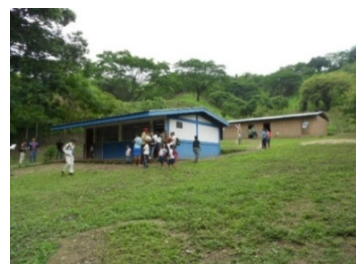
▲斜面の一部を平面に削って建設
