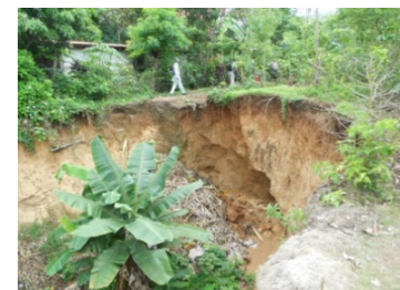
▲深さ10メートル級で拡大し続ける浸食地
